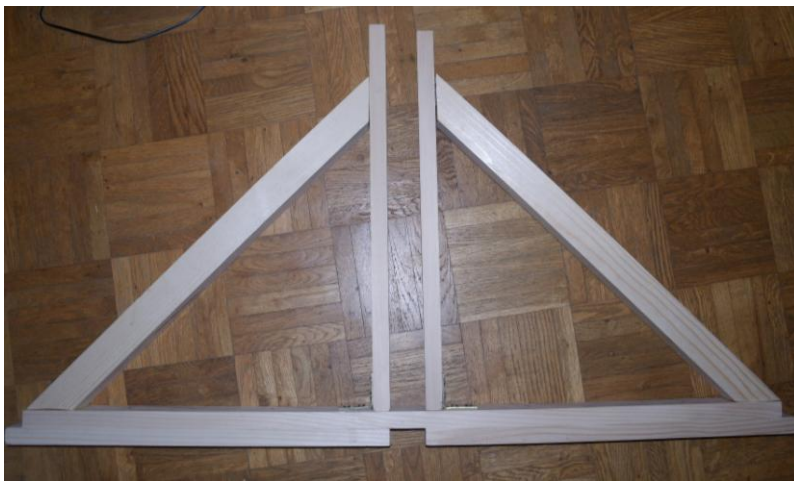
Abb. 3: Installiere Querbalken
